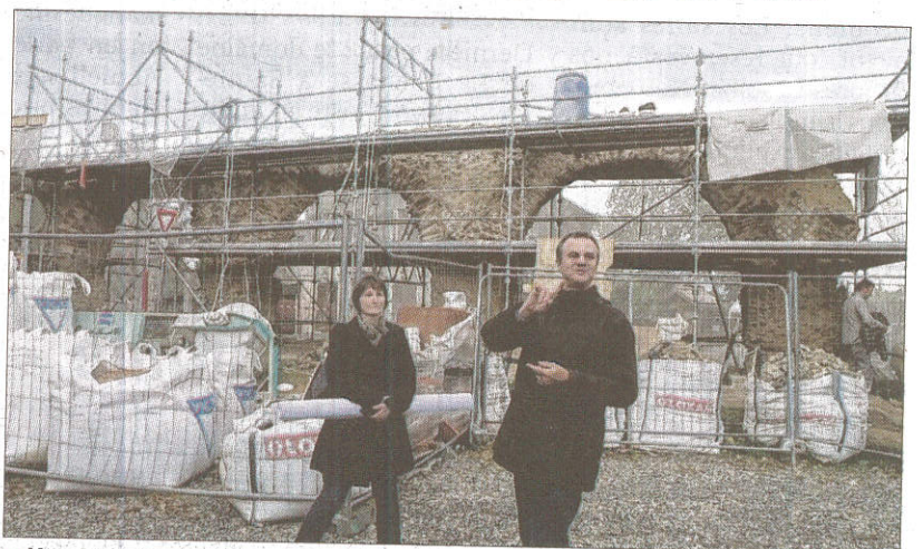
■ L'architecte des monuments historiques explique que la particularité de ce monument vient de son parement réticulé, des petites pierres à face carrée de 10 cm de côté, disposées en biais et évoquant les mailles d'un filet. Photo Laurence SACCU
