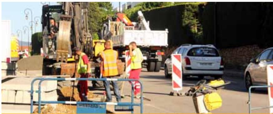
Depuis 2000, des travaux sont conduits pour améliorer la qualité des réseaux d'assainissement, dans le cadre du schéma général d'assainissement de la commune. Des travaux de séparation des eaux usées et des eaux pluviales vont ainsi être entrepris au 1<sup>er</sup> semestre 2018 sur le secteur Garby-Doumer, qui souffrait jusqu'ici de refoulements dans certaines propriétés et de mise en charge du réseau. Un diagnostic complet a été réalisé et a mis en avant la nécessité de réaliser :
